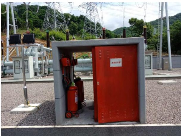
图 6-5 消防室及站内硬化
