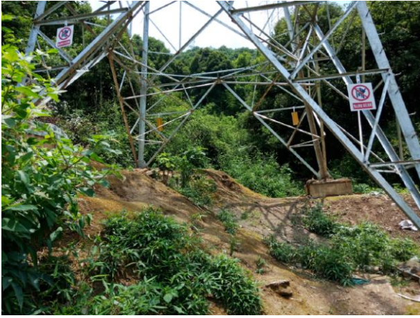
图 6-7 塔基迹地现状 1
