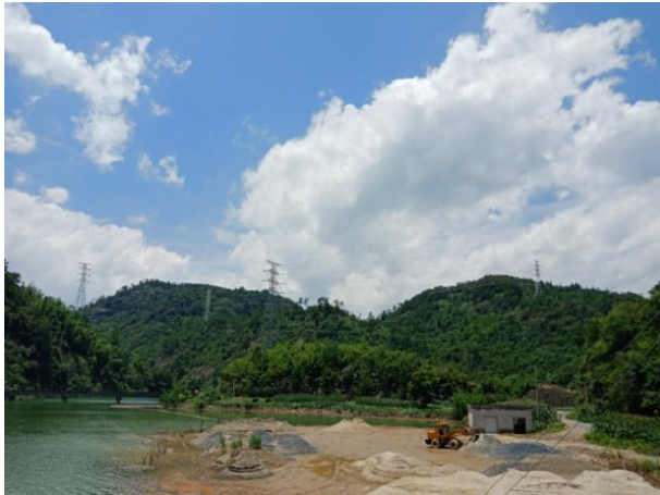
图 6-3 线路跨越的郁川溪
