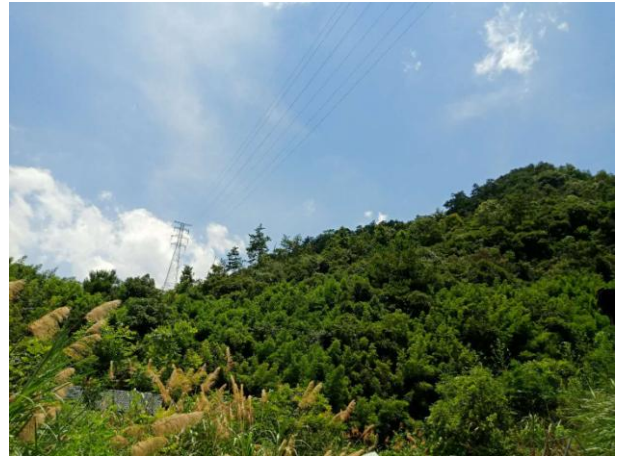
图 6-2 线路沿山地走线现状 2
