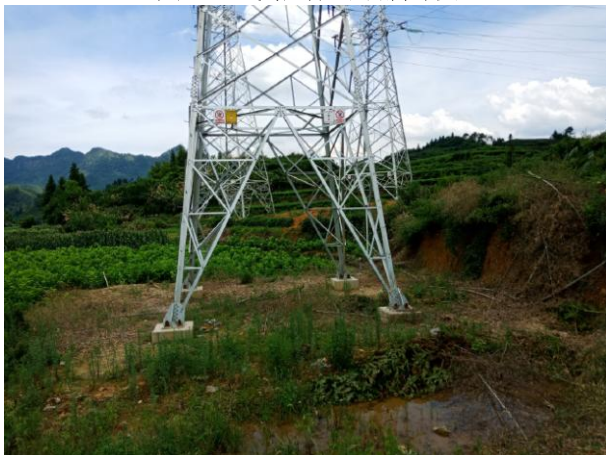
图 6-5 塔基迹地现状 1
