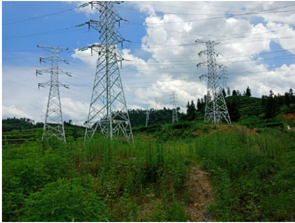
图 6-1 线路沿山地走线现状
