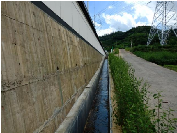
图 6-11 变电站西侧围墙外排水沟
