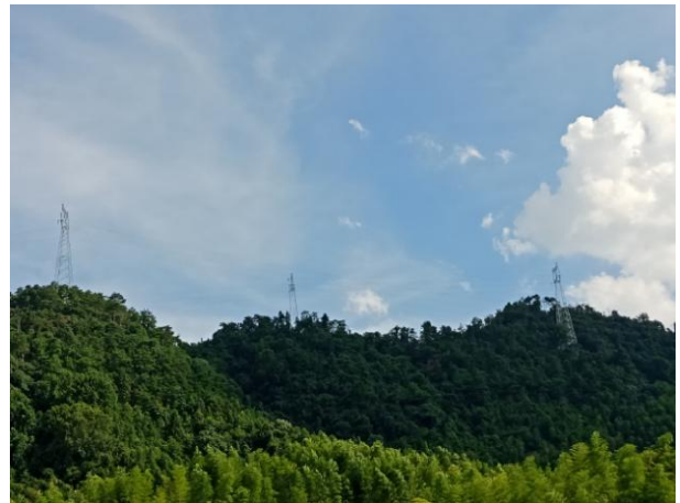
图 6-12 线路沿山地走线现状 1
