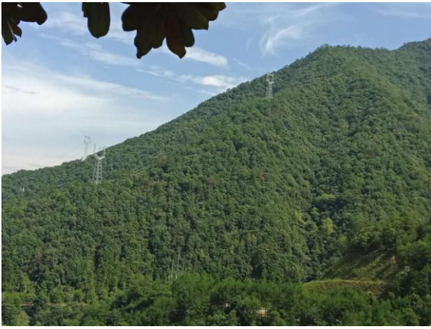
图 6-13 线路沿山地走线现状 2
