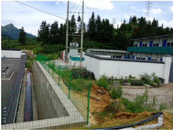
图 6-9 变电站南侧现状
