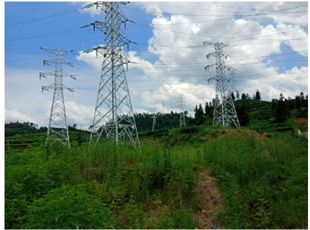
图 6-10 变电站东侧现状
