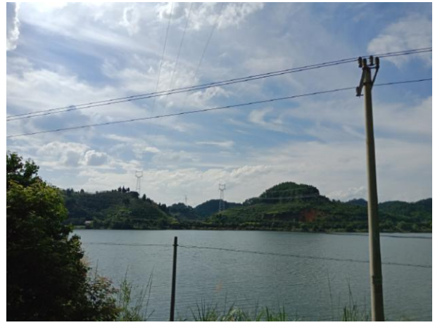
图 6-14 线路跨越的楼底溪现状
