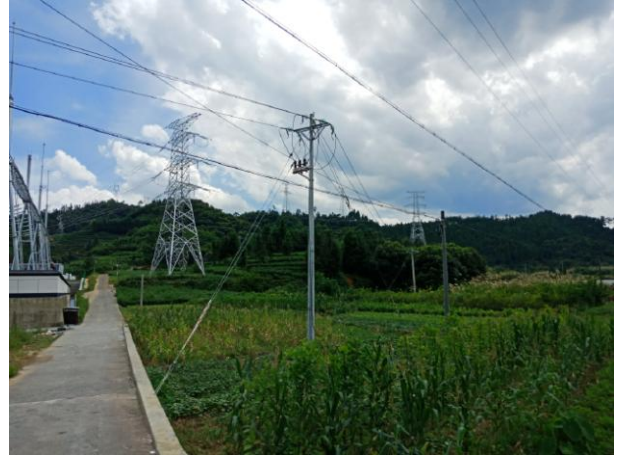
图 6-8 变电站西侧现状
