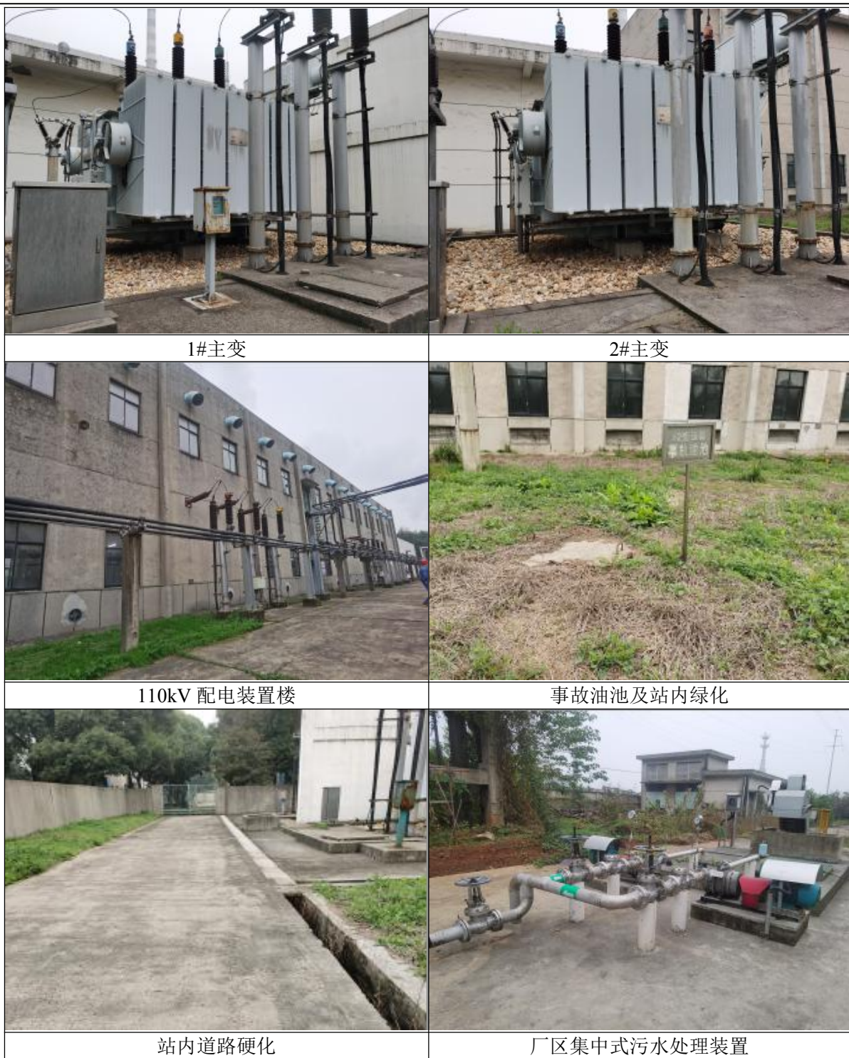
图 1-1 变电站已建工程现状照片
