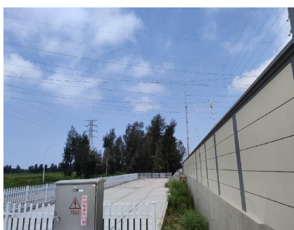
电缆沟迹地现状
