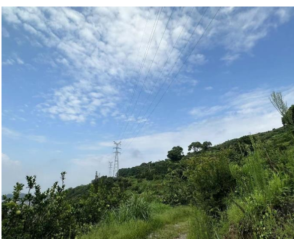
线路沿山地走线现状
