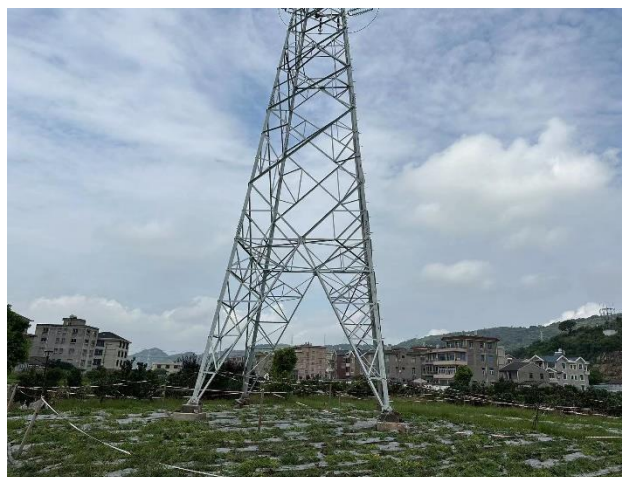
塔基迹地现状
