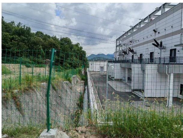
东佛 220kV 变电站扩建间隔侧现状
