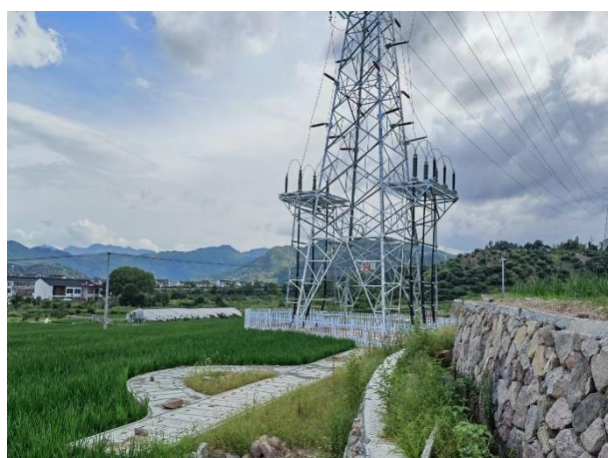
电缆终端塔现状
