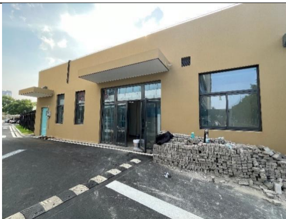
北侧高压氧舱
