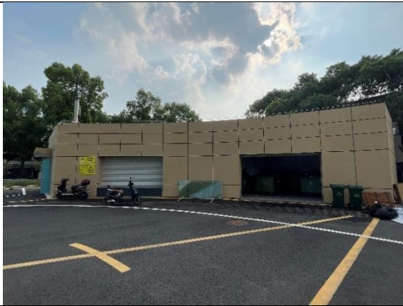
西侧医疗废物暂存点
