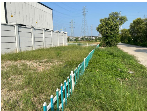
变电站西南侧
