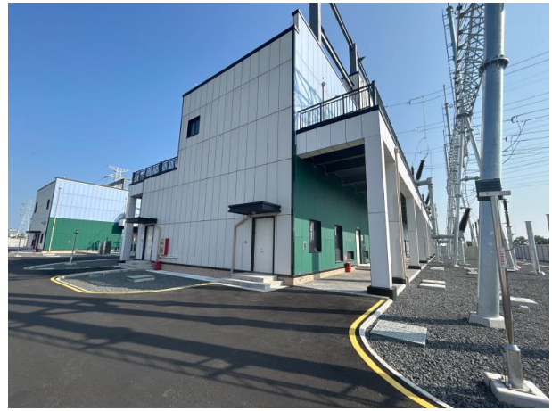
220kV 配电装置楼
