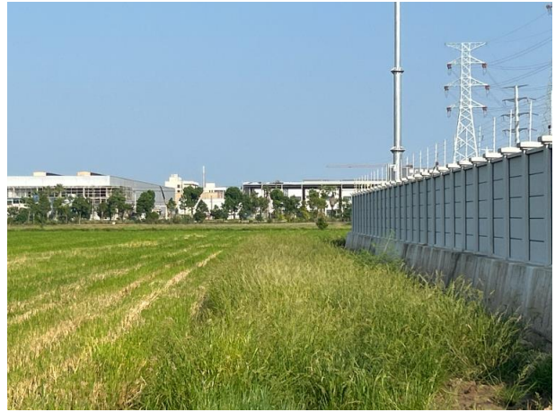
变电站东北侧
