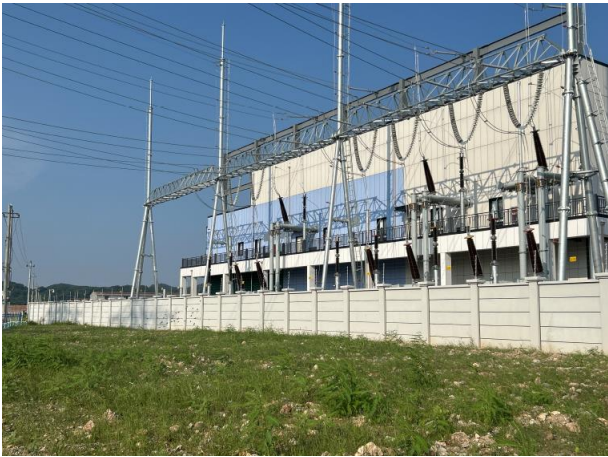
变电站西北侧
