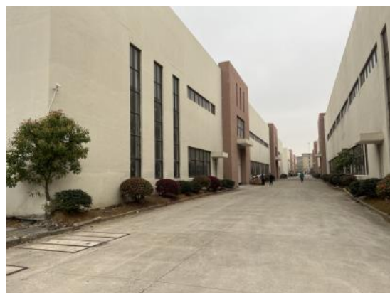
拟建加速器机房南侧现状（南侧道路和车间 3）
