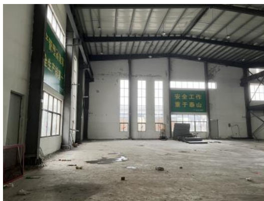
加速器机房拟建区域现状（闲置区域）
