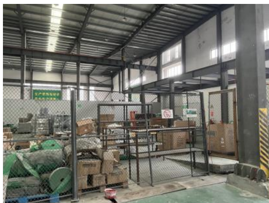
拟建加速器机房北侧现状（原材料仓库）
