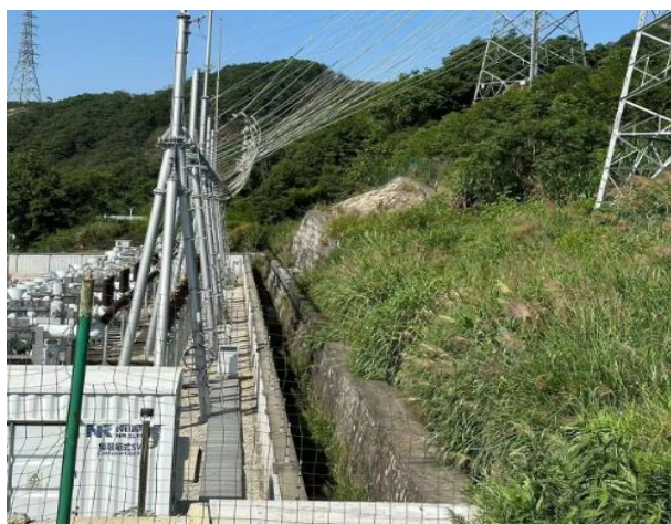
变电站南侧（间隔扩建侧）
