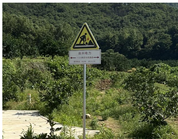
电缆井警告标志
