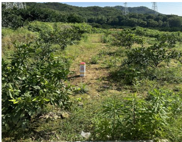
电缆井上方植被恢复
