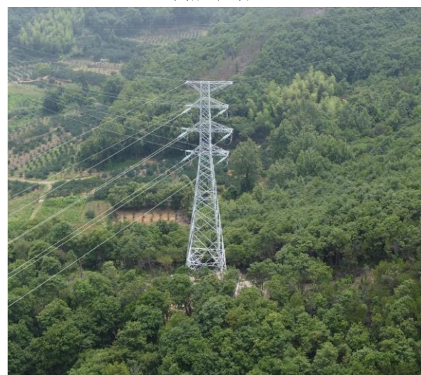
塔基迹地现状 1（三门县施家岙水库水源涵养生态保护红线内）
