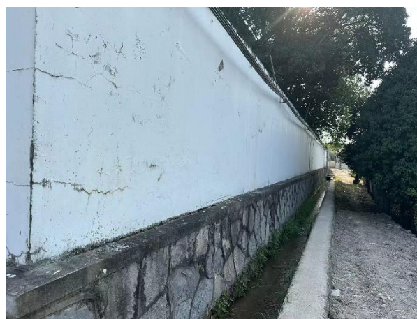
220kV 变电站间隔扩建侧
