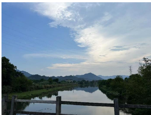
线路跨越苍山倒溪
