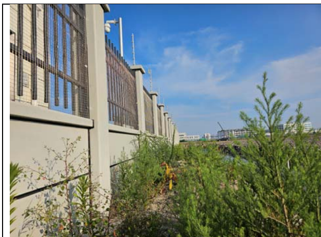
变电站西南侧
