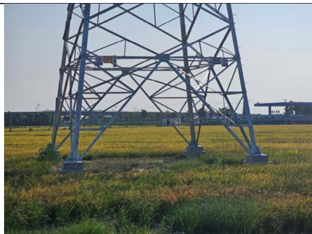
塔基迹地现状
