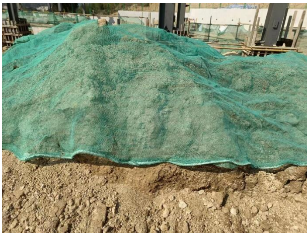
施工期堆土覆盖
