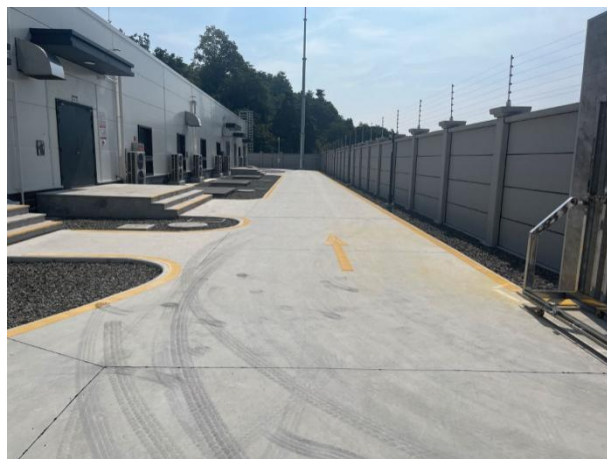
站内道路及硬化
