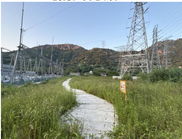
电缆线路施工区域生态恢复现状
