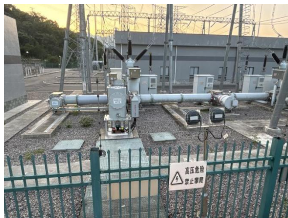
220kV 钱金变间隔扩建区域（八岱间隔）
