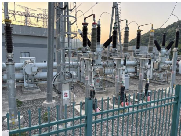
220kV 钱金变间隔扩建区域（钱库间隔）
