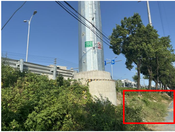
拆除塔基位置恢复现状
