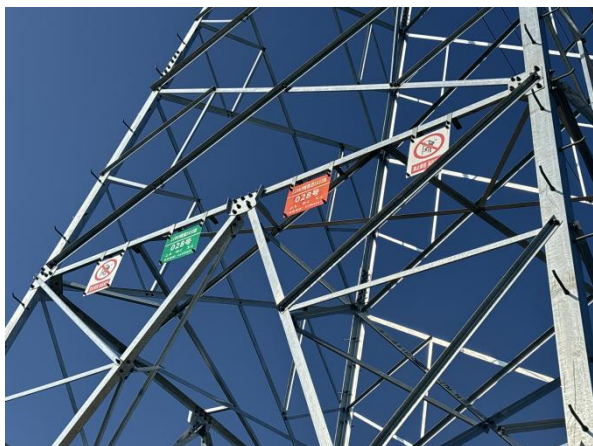
塔基相序牌及线路警告标志
