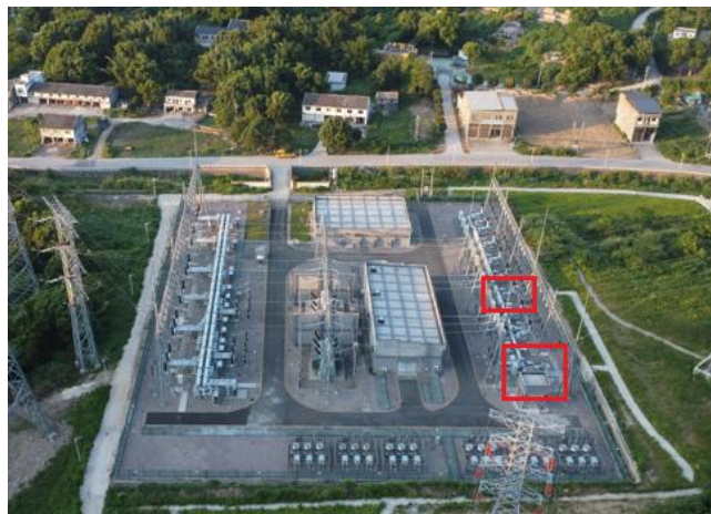
220kV 钱金变间隔扩建位置
