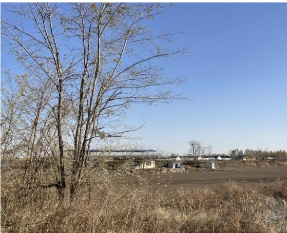
6、施工临时占地 2（施工场地）
