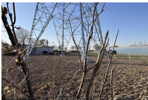
3、塔基恢复情况
