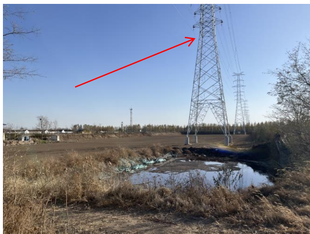
图 4-1 输电线路周围现场照片（220kV/110kV 同塔四回路（220kV 合军 I 线、合军 II））
