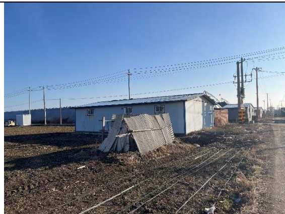
12、三跃线、三台线 9#-10#线路南侧 16m 信老村北侧大棚看护房
