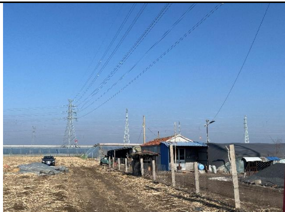
7、三益线、三马线 3#-4#线路正下方邢西村 东北侧大棚看护房
