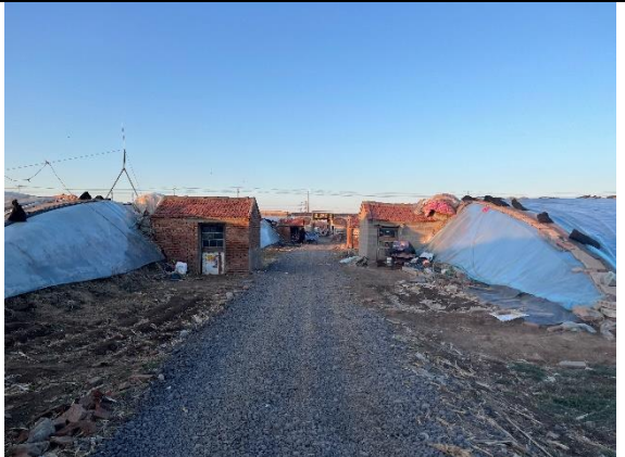
3、三氨线、三金线 24#-25#线路北侧 3m 处后疃村侧大棚看护房
