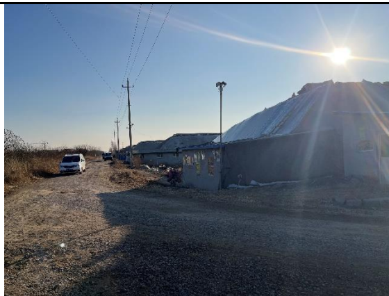
13、三跃线、三台线 1#-2#线路南侧 7m 处邢西村西北侧大棚看护房
