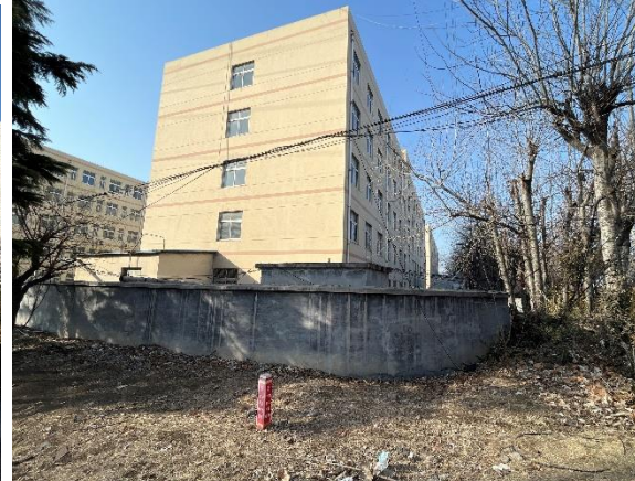
6、三金线 53#- 54#、三氨线 54#线路南侧 14m 处山东联盟化工股份有限公司
