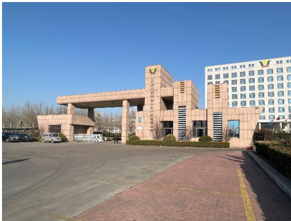
5、三金线 52#-53#线路北侧 28m 处山东寿光巨能玉米开发有限公司厂区门卫室
