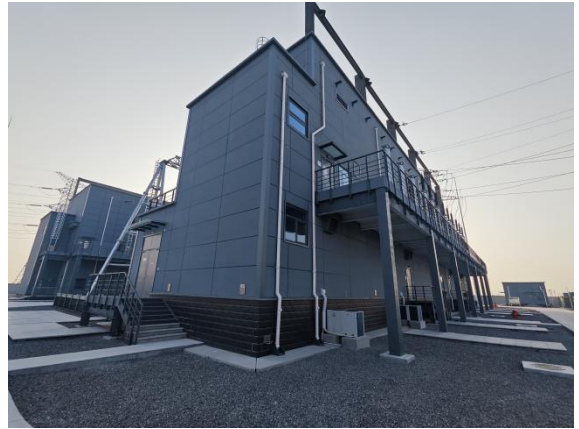
图 4-8 110kV 配电装置楼
