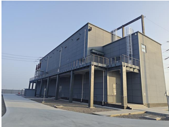
图 4-7 220kV 配电装置楼
