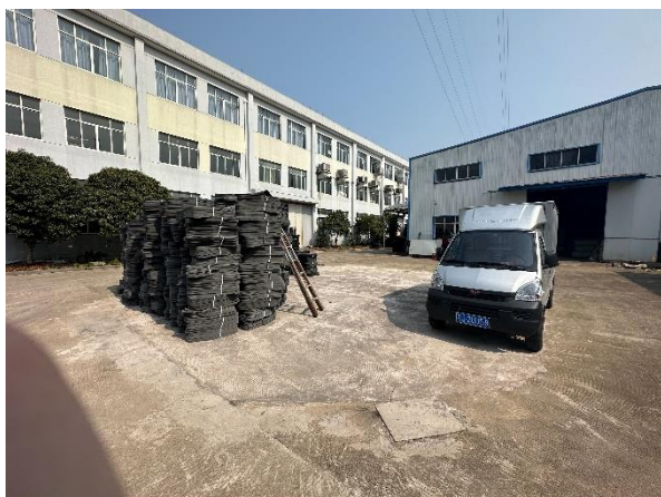
塔基拆除现状
