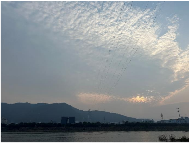
线路跨越始丰溪
