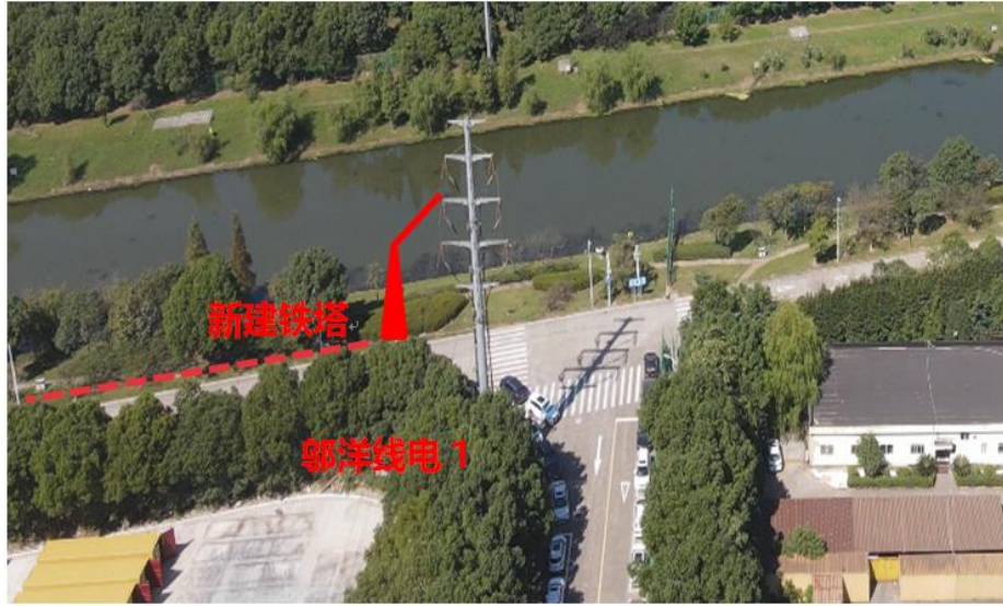
图 2 新建电缆终端塔附近现状
