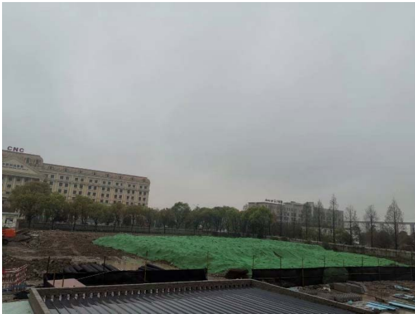
施工期堆土苫盖
