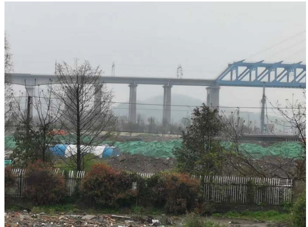
施工期设置硬质围栏、施工现场苫盖
