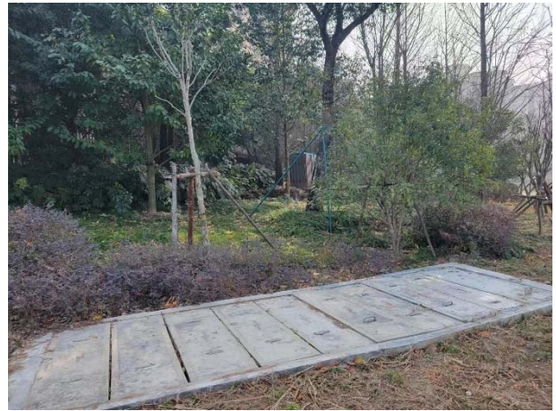
电缆沟迹地现状
