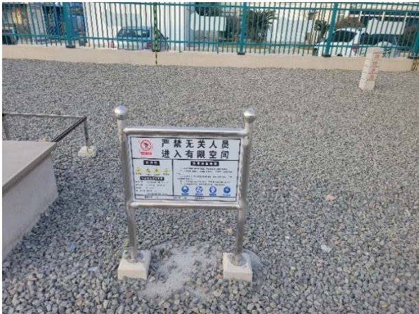
变电站内警告标识
