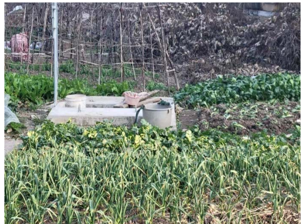
电缆沟基地现状
