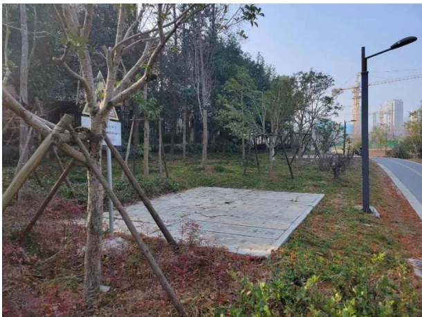
电缆沟迹地现状
