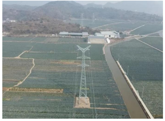
线路沿耕地、山地走向现状
