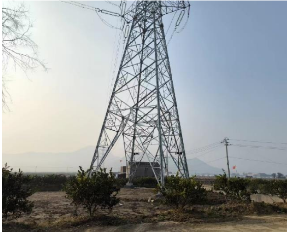
塔基迹地现状 1
