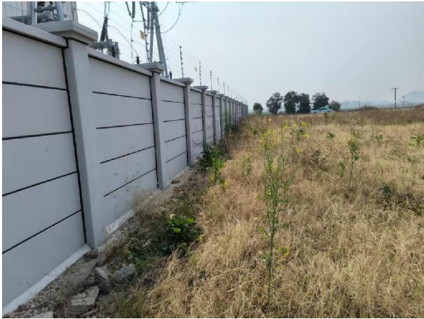
珊瑚 220kV 变电站扩建间隔侧绿化
