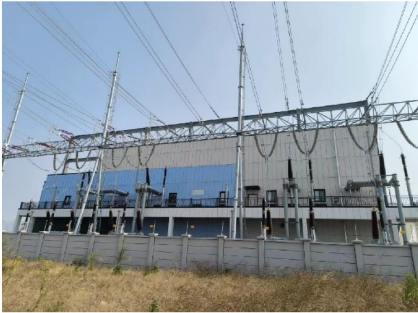
珊瑚 220kV 变电站扩建间隔侧现状
