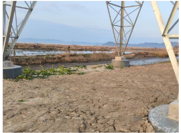
塔基迹地现状 2
