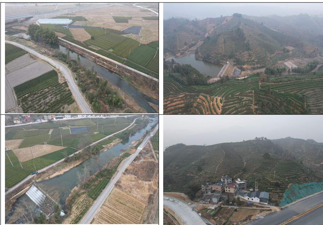
光伏场区现状照片
