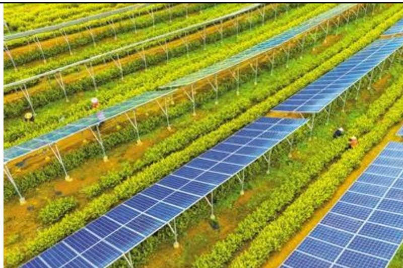
图 2-7 光伏阵列安装实景照片
