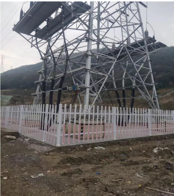
电缆终端塔基现状 (2)
