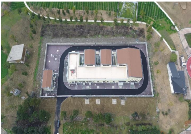
龙舟变电站俯视图
