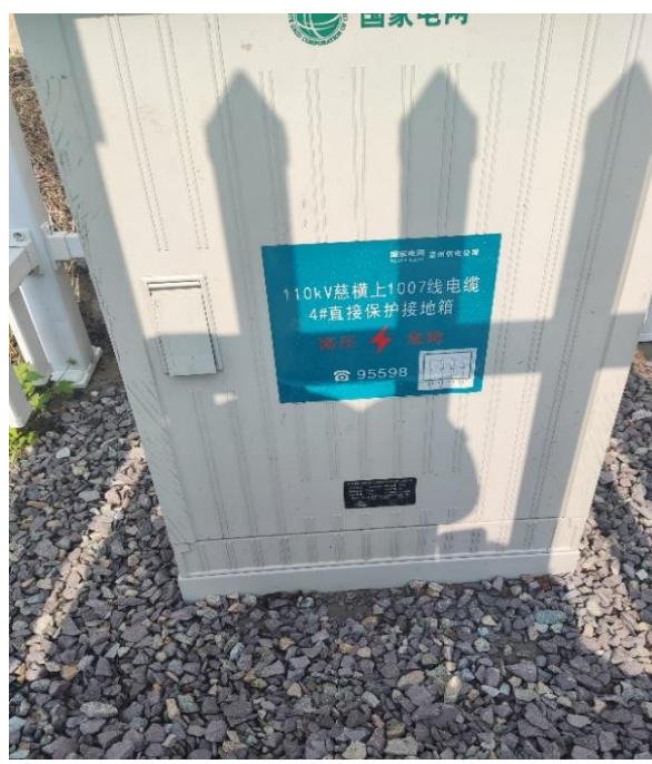
电缆直接保护接地箱
