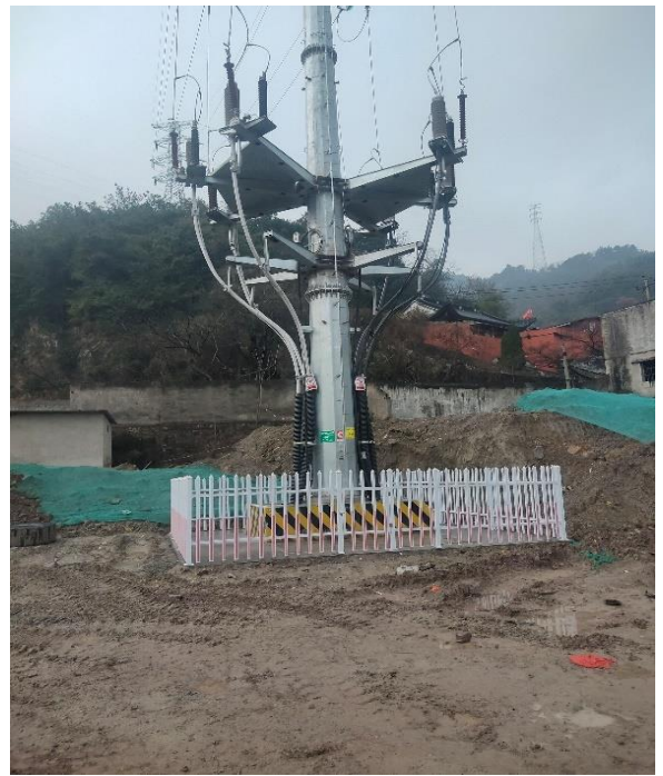
电缆终端塔基现状 (1)
