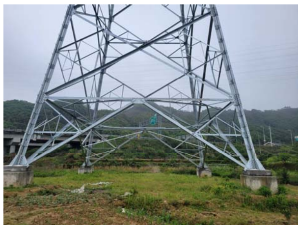
塔基迹地现状
