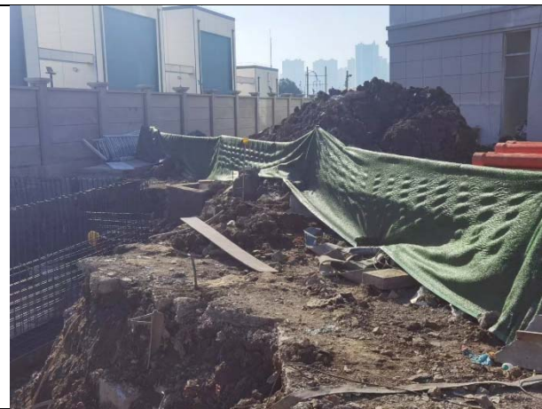
施工期堆土苫盖
