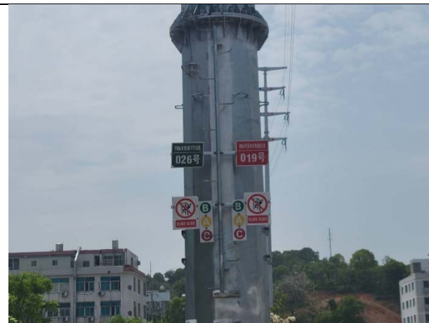
塔基警告标识
