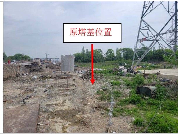
拆除塔基现状（现为道路施工临时占地）
