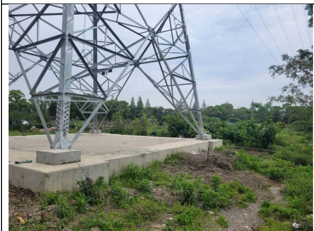
塔基迹地现状
