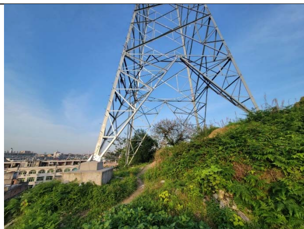
塔基迹地现状
