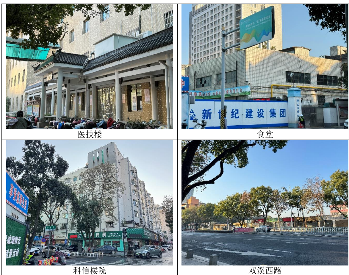
图 8-1 DSA 机房周围环境现状照片
