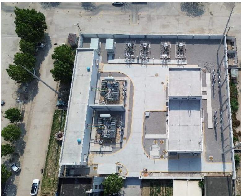
变电站现状俯视图
