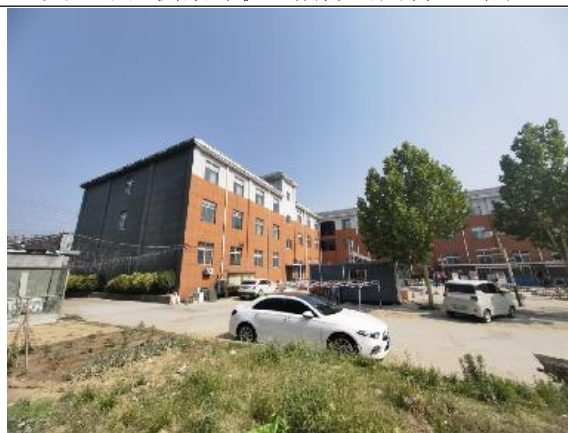
变电西北侧 23m 驾校办公用房（3 层）
