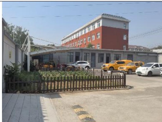
变电站西侧紧邻供电所办公用房（1 层）
