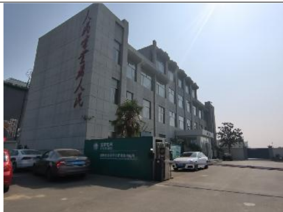
变电站西侧紧邻供电所办公用房（4 层）
