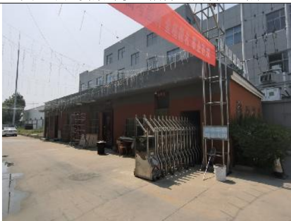
变电西北侧 17m 驾校办公用房（1 层）
