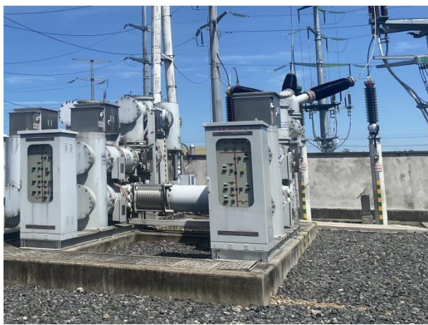
本项目间隔扩建区（近景）
