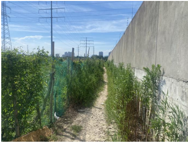
站址西侧现状
