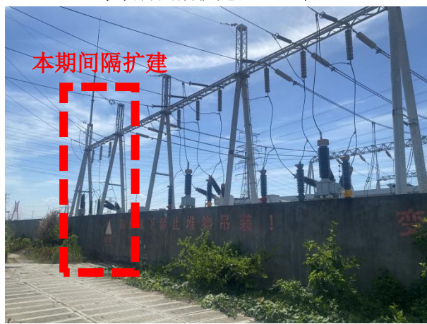
本项目间隔扩建侧围墙（南墙）外生态恢复
