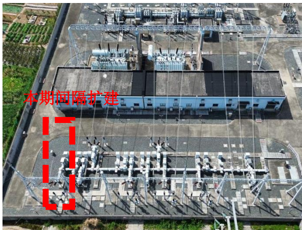
本项目间隔扩建区（航拍远景）
