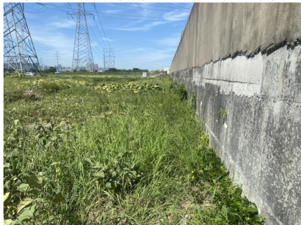
站址北侧现状
