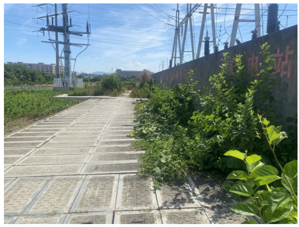
站址南侧现状
