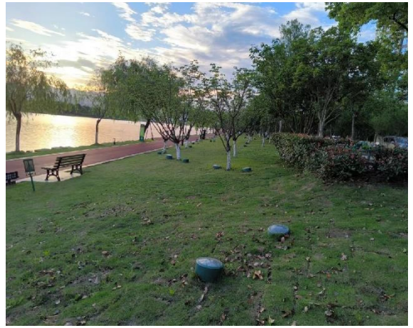
电缆施工道路恢复现状
