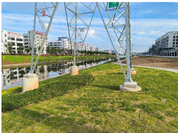
110kV 三清 1743 线#5/110kV 龙三祥 1387 线 #63 塔基迹地现状
