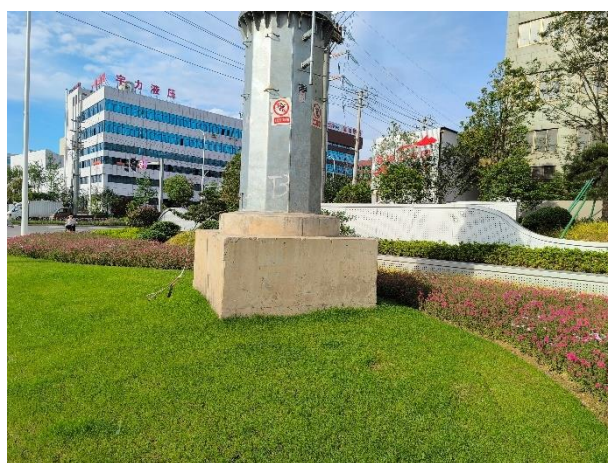
110kV 象自 1219 线#40/110kV 三创 1742 线#3 塔基迹地现状
