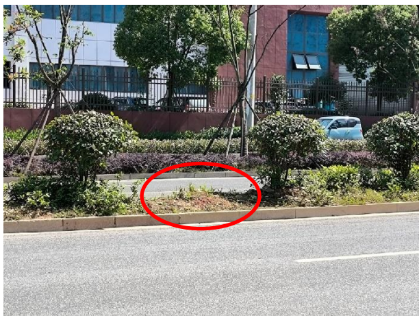
拆除杆塔现状 1
