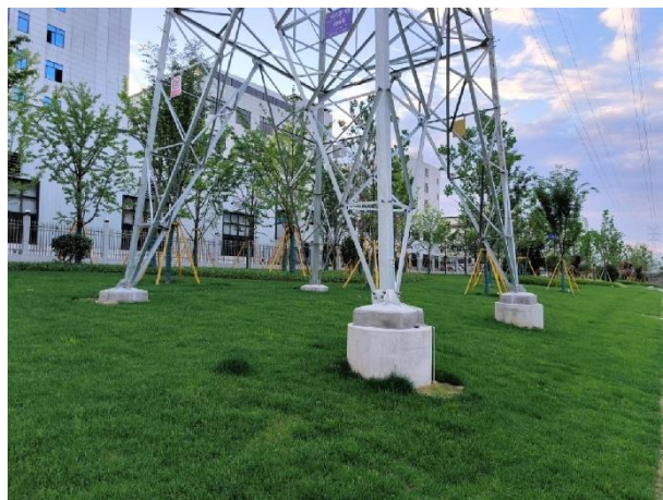
110kV 三清 1743 线#6/110kV 龙三祥 1387 线 #62 塔基迹地现状
