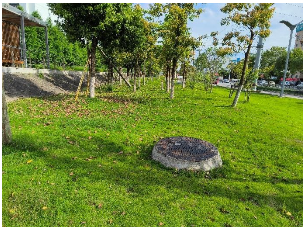
电缆迹地现状 1
