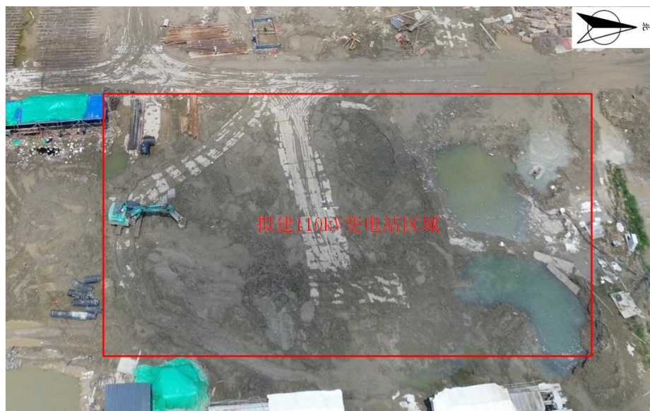
图2.1-1 拟建变电站区域现状照片
