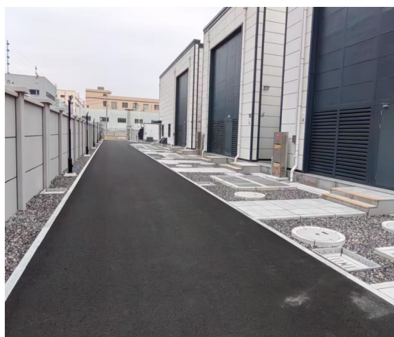
站内道路及地面硬化
