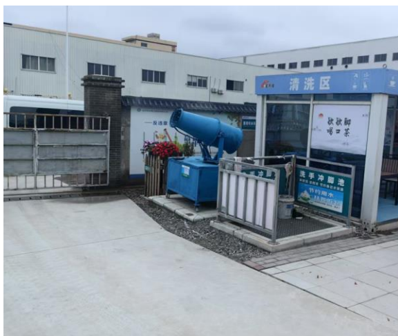
施工期环保措施照片（定点冲洗区）
