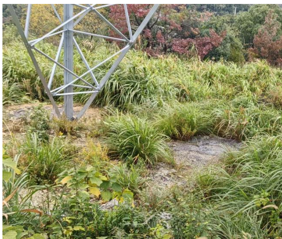
电 13 塔基迹地现状
