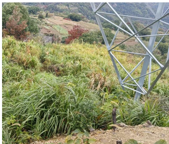
电 15 塔基迹地现状
