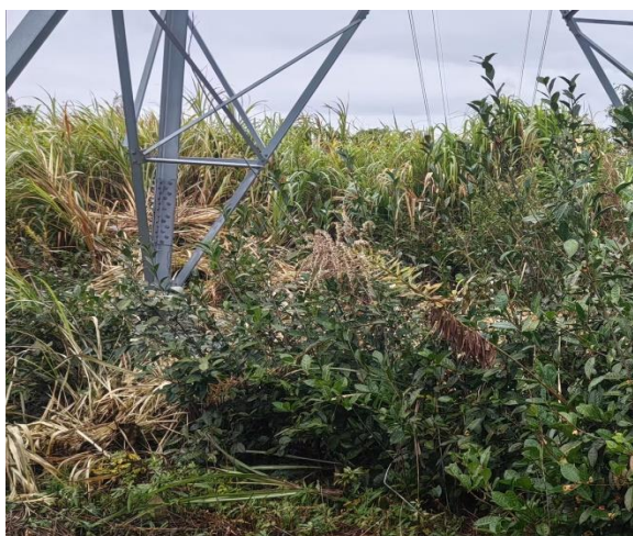
电 9 塔基迹地现状
