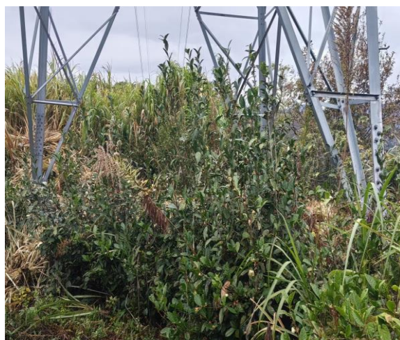
电 11 塔基迹地现状
