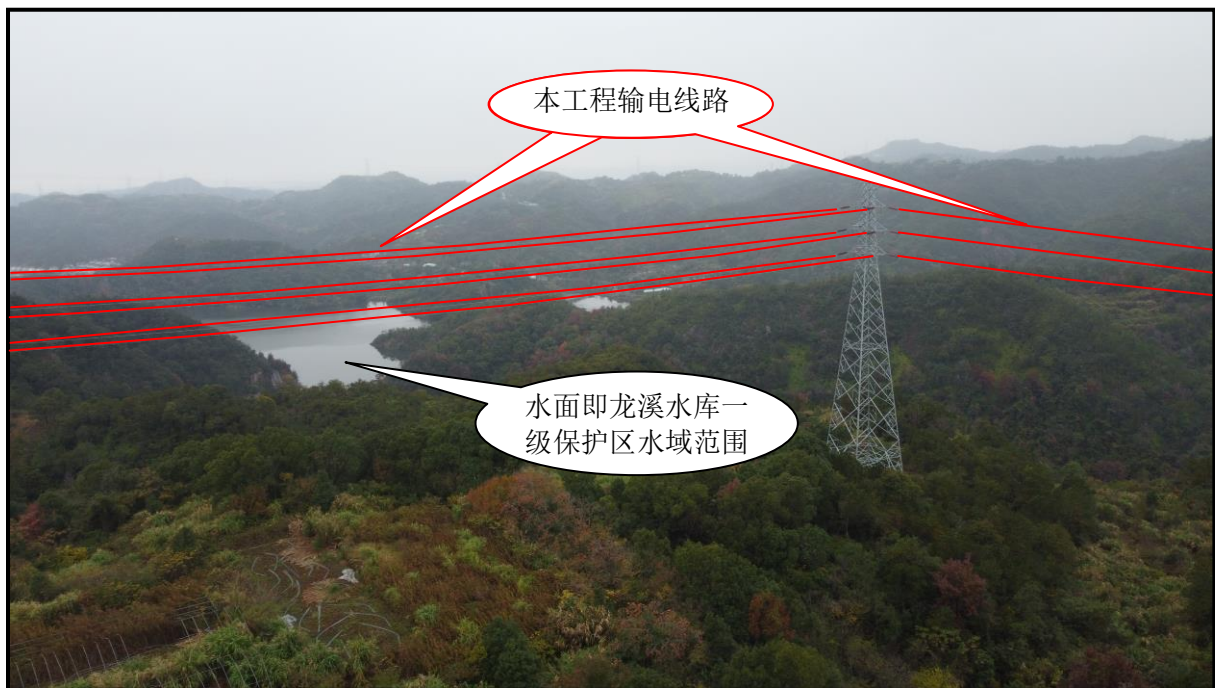
图 8-1 电 10 塔基及周边环境现状
