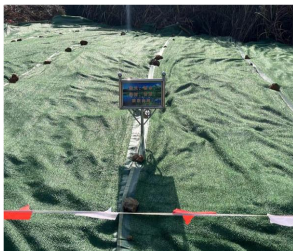
施工期环保措施照片（土方覆盖防扬尘）
