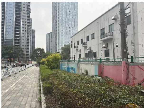
变电站厂界东侧
