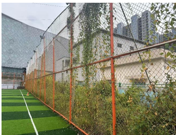
变电站厂界北侧
