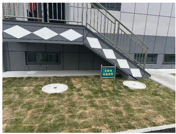
化粪池 (定期清掏)
