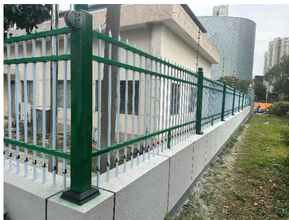
变电站厂界南侧
