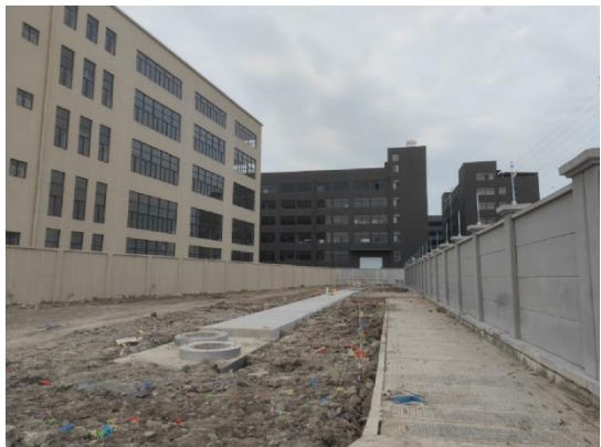
站址西侧现状
