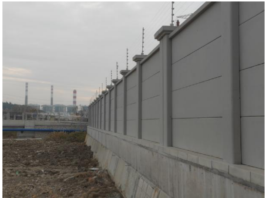
站址东侧现状
