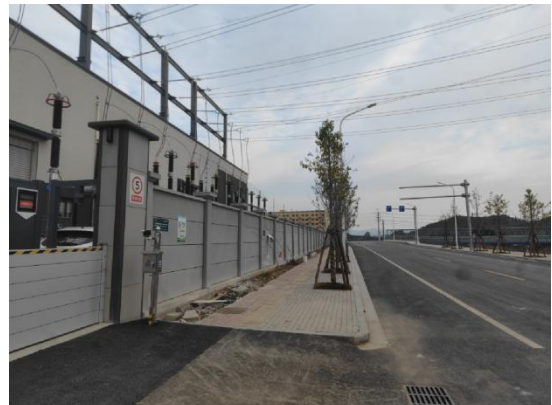
站址南侧现状
