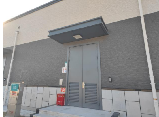
本项目间隔扩建区域（近景）
