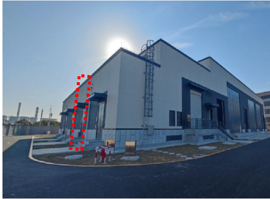
本项目间隔扩建区域（远景）
