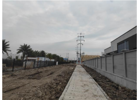
站址北侧现状
