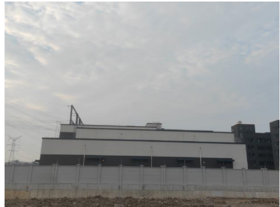
本项目间隔扩建侧东墙外
