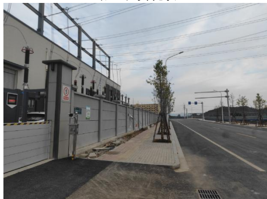
站址南侧现状
