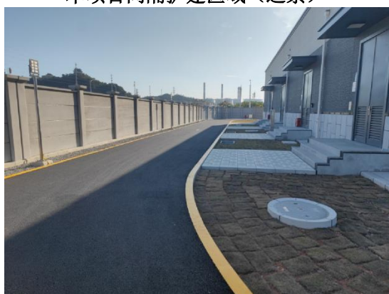
110kV 出线侧区域
