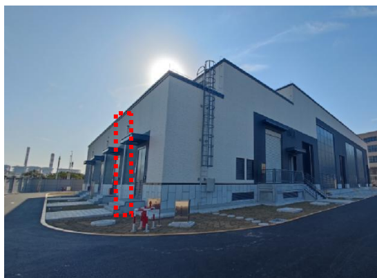
本项目间隔扩建区域（远景）
