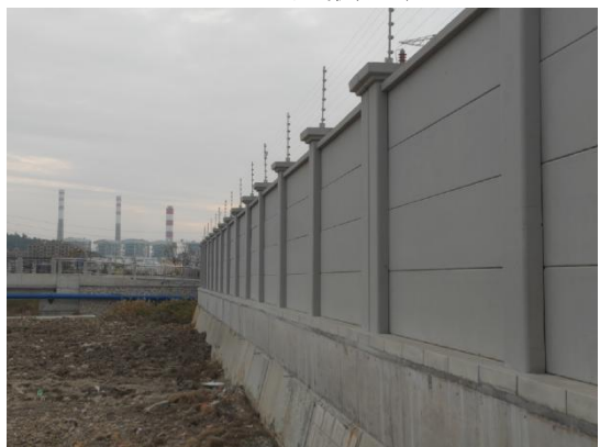
站址东侧现状
