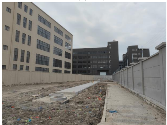
站址西侧现状
