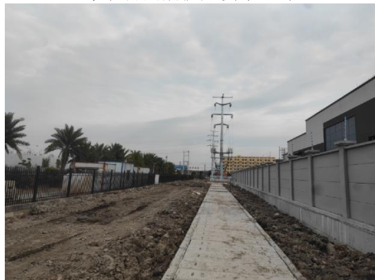
站址北侧现状
