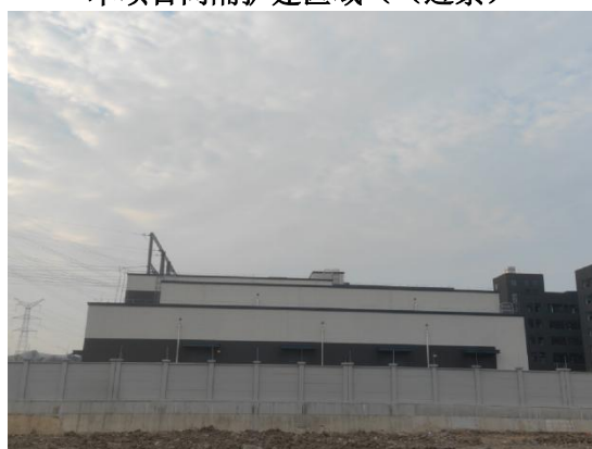
本项目间隔扩建侧东墙外
