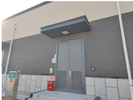
本项目间隔扩建区域（（近景）
