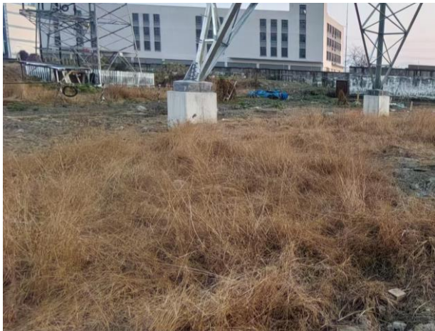
#24 塔基恢复情况
