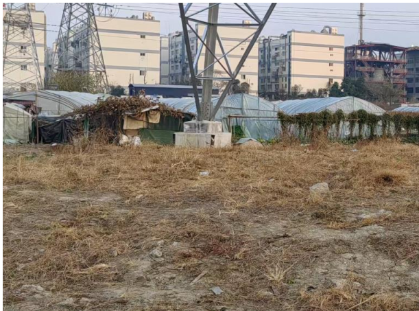
#25 塔基恢复情况
