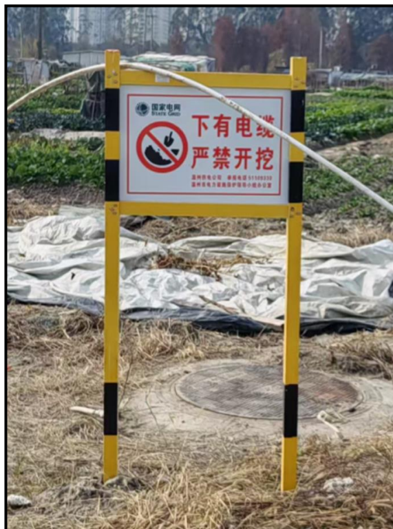
图 7-1 本工程输电线路西侧地下电缆标志牌
