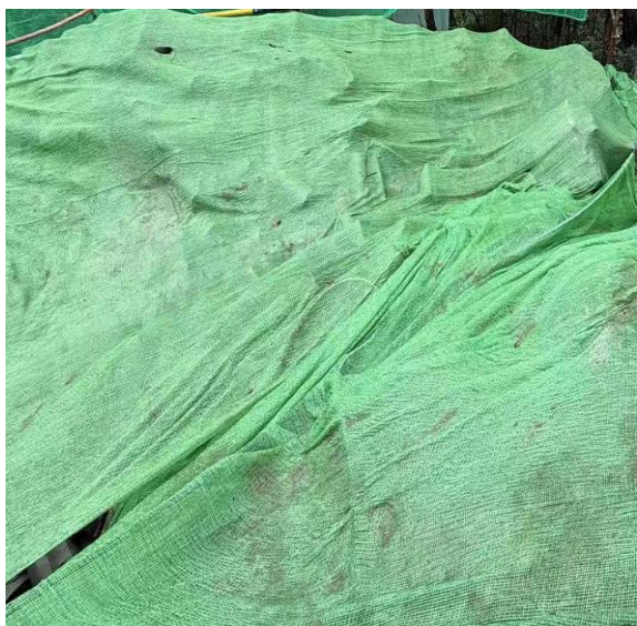
施工期环保措施（防扬尘措施）
