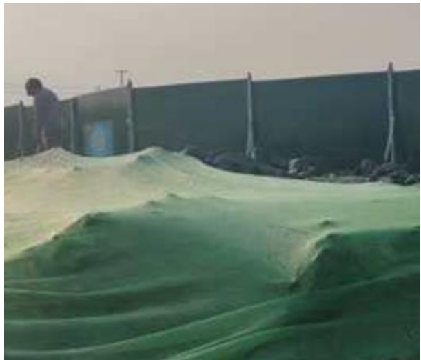
施工期环保措施（硬质围挡）
