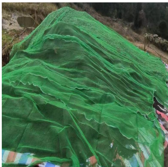
施工期环保措施（土方覆盖）
